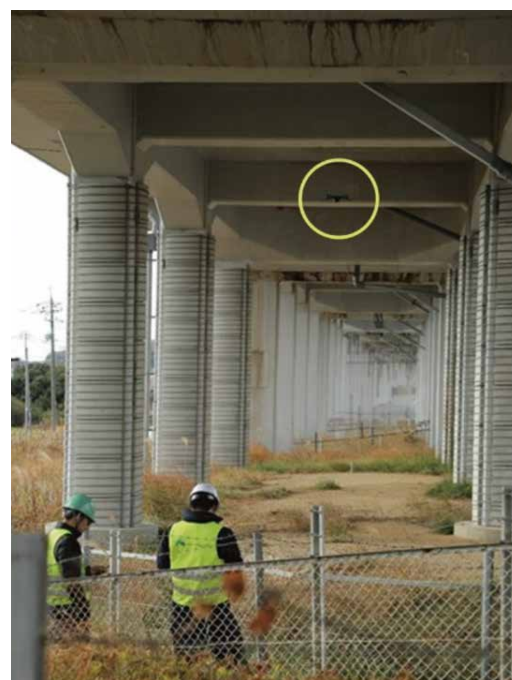
新幹線高架下点検状況
