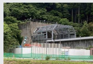
図2：建設途中の吸音型緩衝工
