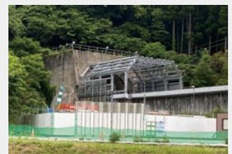
図2：建設途中の吸音型緩衝工
