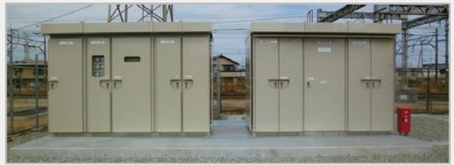
写真2：電力貯蔵装置(東海道線野洲き電区分所)
