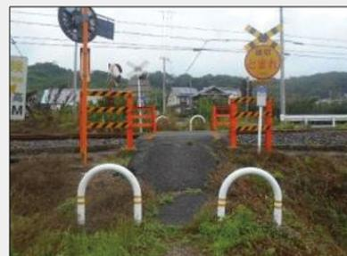
写真1：交通規制杭の設置例
