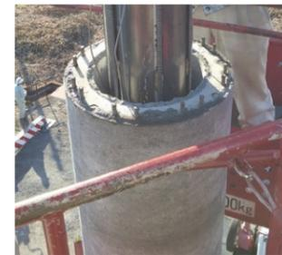
図3: 鋼管挿入作業
