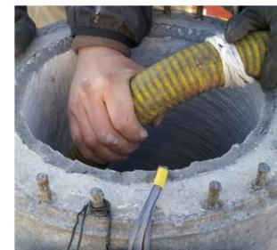
図5: モルタル充填作業
