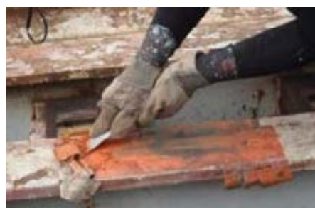
写真3：加熱後の塗膜除去作業
