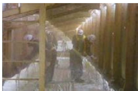
写真1：電力工具による塗膜除去作業
