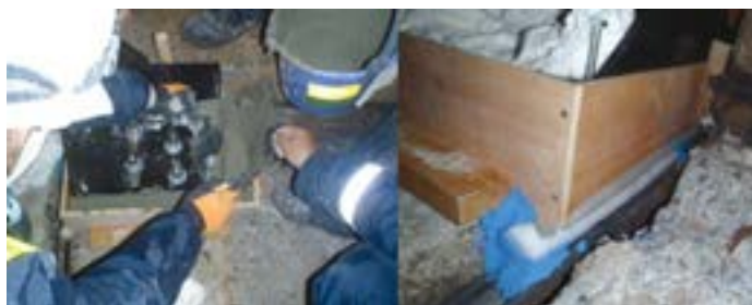
写真2：狭い区間への材料注入、材料漏れ防止
