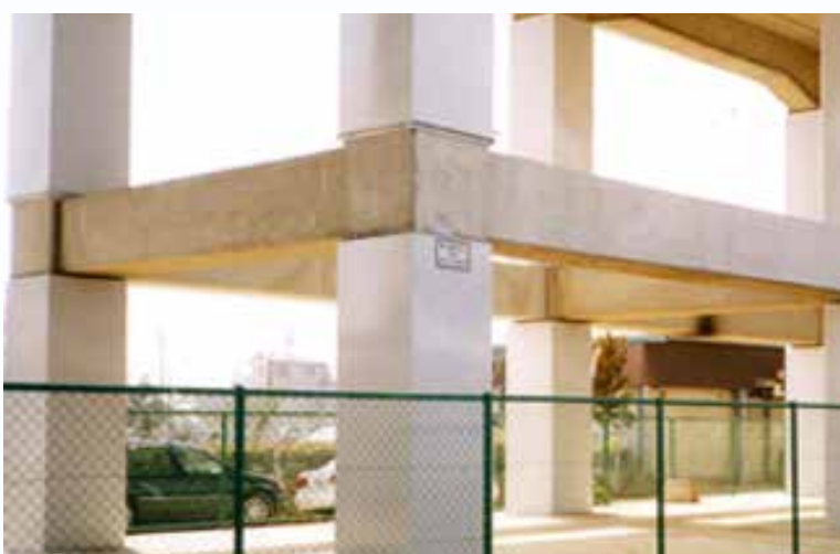
高架橋の補強イメージ
