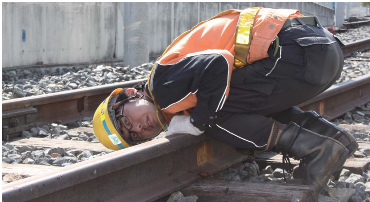
自らの目で線路の状態を確認しています。
