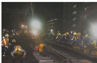
【グループ会社による夜間工事】
