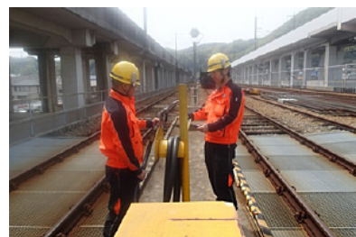
給油設備（危険物施設）の点検
