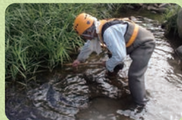
⑦ 伯備線護岸工事 オオサンショウウオ生息調査
