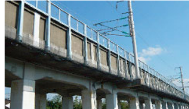
新幹線の防音壁
