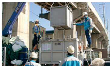
PCB搬出作業
