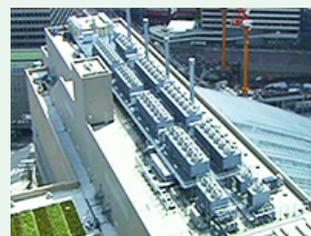
大阪駅ノースゲートビルディング地域冷暖房プラントは、熱源を電気・ガス併用のベストミックスとし、インバーターボ冷凍機や氷蓄熱槽を設けることで、ルクア等からの需要に効率よく対応できる機器構成としており、継続的な運用改善を実施していることが評価されました。
