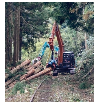
旧線路敷での重機を使った木材集積作業
