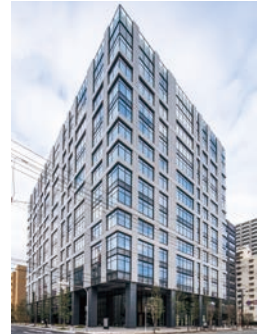
新大阪第2NKビル (2022年1月竣工)
