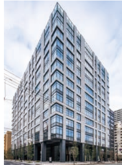
新大阪第2NKビル (2022年1月竣工)
