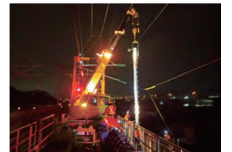
新幹線用電柱建替車
