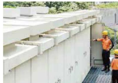
列車のブレーキ時に発生する回生電力を蓄電し、他電車に供給活用する電力貯蔵装置を導入
