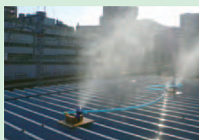
ホーム屋根への散水
