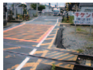
奈良線木幡駅踏切
