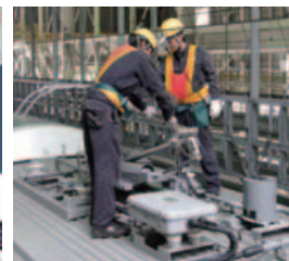
網干総合車両所での車両検査
