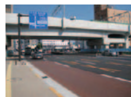
大和路線奈良駅付近
