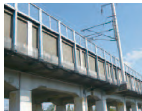
新幹線の防音壁
