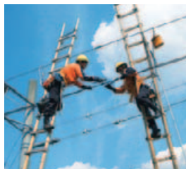
和歌山支社での架線点検訓練
