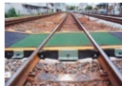
レールとまくらぎの間で列車の衝撃を緩衝するために使用しているゴムパッドをチップ化し、踏切路盤材としてリサイクルしています。
