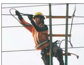
架線保守の訓練
