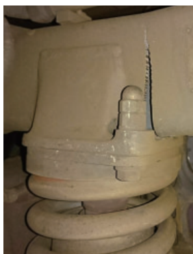
新幹線台車枠に発生した亀裂
