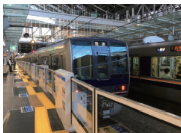
ホーム柵の整備
