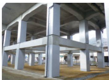
建物や高架橋などの耐震補強
