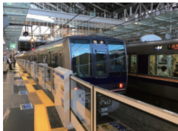
ホーム柵の整備
