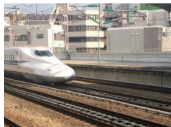
逸脱防止ガードの整備
