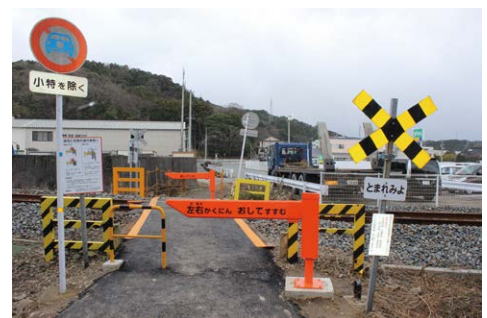
第4種踏切の踏切ゲートの導入拡大
