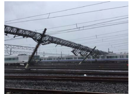
吹田総合車両所 日根野支所 強風による電化柱倒壊 (2018年9月 台風21号)
