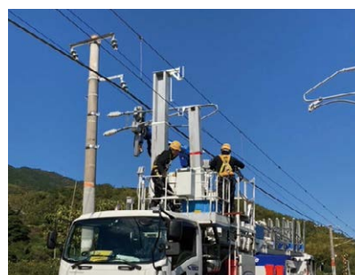
電車線金具の取替
