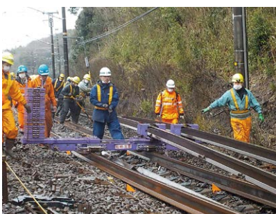
検査結果に基づくレール交換
