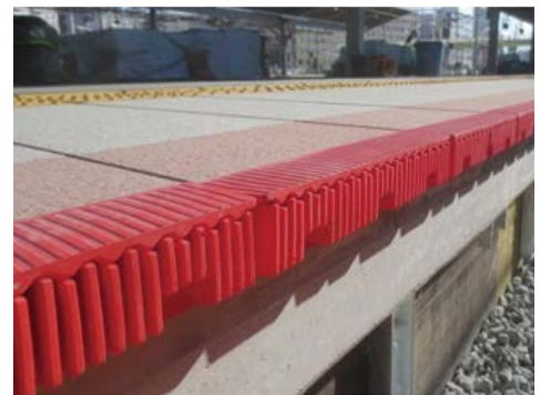
ホームと車両の隙間対策の実施
