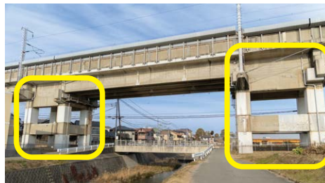
ラーメン橋台
