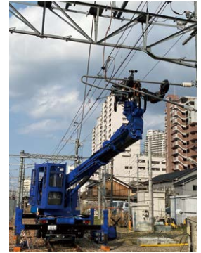
多機能鉄道重機の導入
