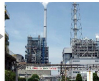
発電やボイラーの燃料として活用
