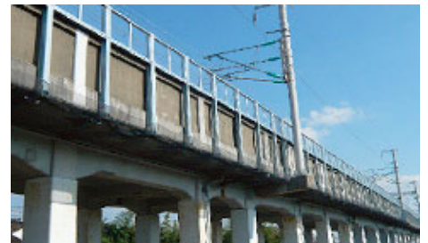
新幹線の防音壁
