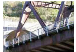
耐候性鋼材を使用した橋梁
