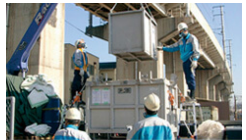
PCB搬出作業
