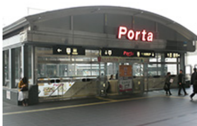
京都駅前地下街「ポルタ」
