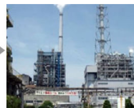
発電やボイラーの燃料として活用
