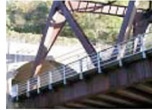
耐候性鋼材を使用した橋梁
