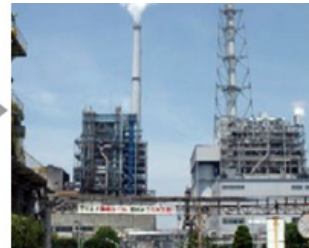
発電やボイラーの 燃料として活用
