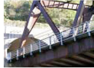
耐候性鋼材を使用した橋梁
