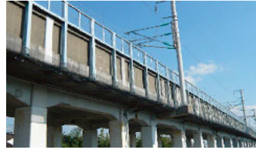
新幹線の防音壁
