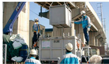
PCB搬出作業
