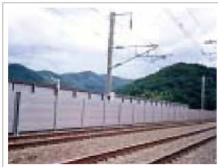
新幹線防音壁・吸音板
