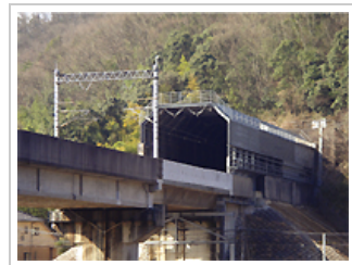
トンネル緩衝工
