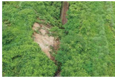
ドローンによる撮影写真
