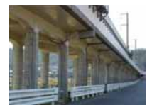
【高架橋耐震補強】
