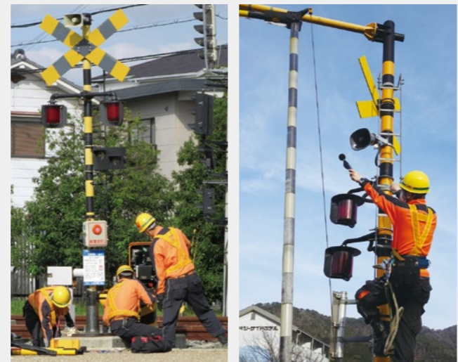
写真2: 踏切設備の検査業務
