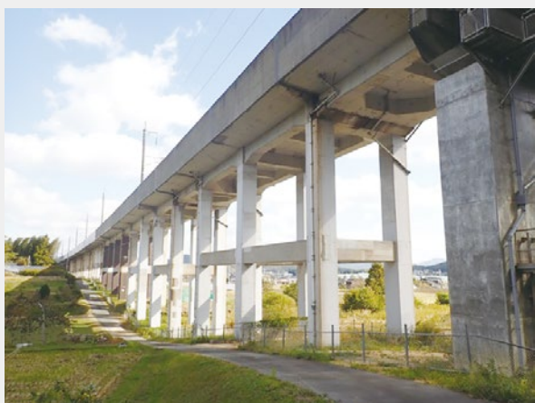
写真1：山陽新幹線RCラーメン高架橋
