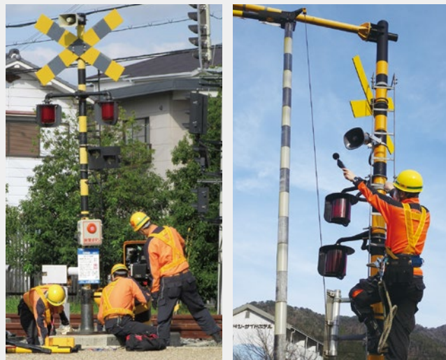
写真2：踏切設備の検査業務
