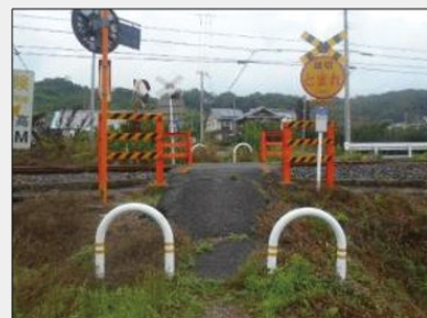
写真1：交通規制杭の設置例
