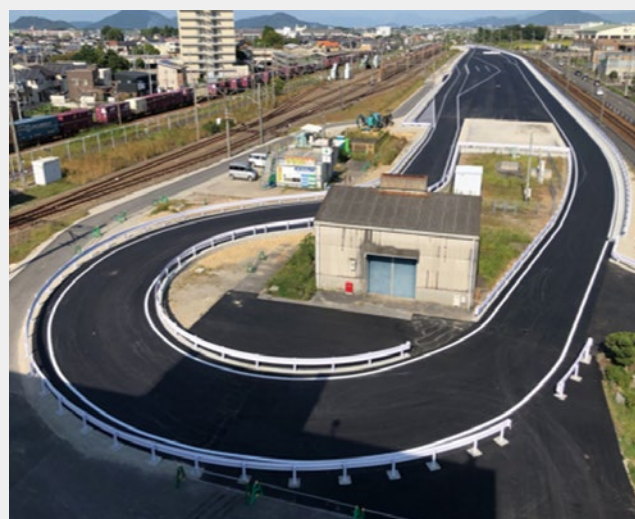
写真1：野洲テストコース施工状況
