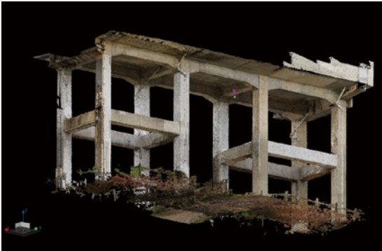
図1：高架橋3Dモデルの作成例
