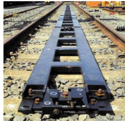
写真1：バラスト軌道用逸脱防止ガード(従来品)
