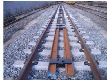
写真2：バラスト軌道用逸脱防止ガード(新形式)
