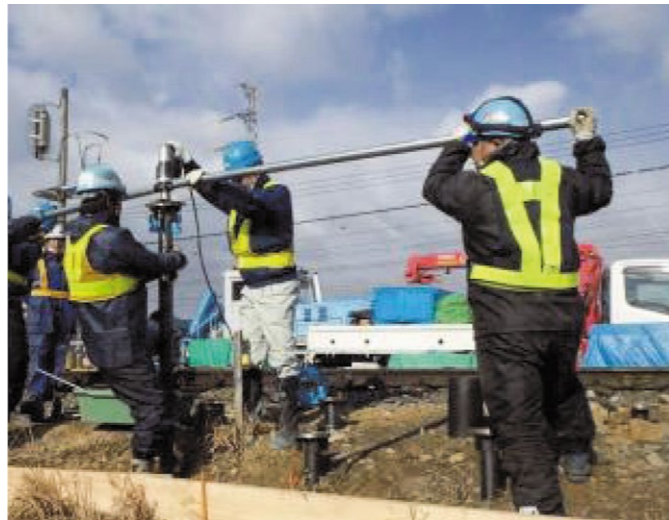
写真1：今回適用した杭の打設状況
