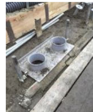
写真3：杭の圧入ガイド設置状況
