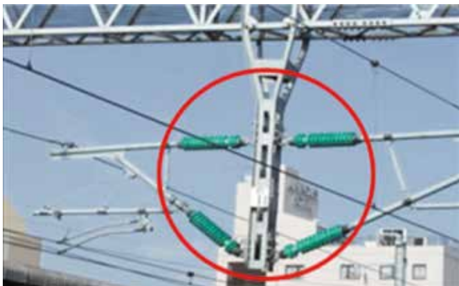
図2：新幹線用長幹がいし（シリコンコンパウンド塗布）
