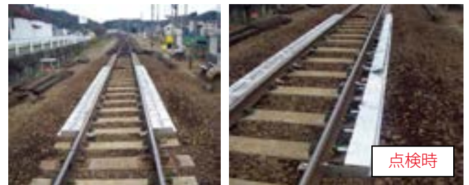
写真4：軌道カバー本設置（山陰線竹野駅）
