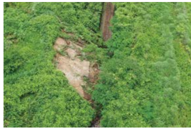
ドローンによる撮影写真
