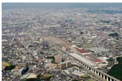
博多総合車両所全景
