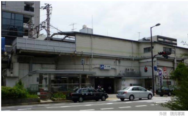
(改良前) 駅舎外観
