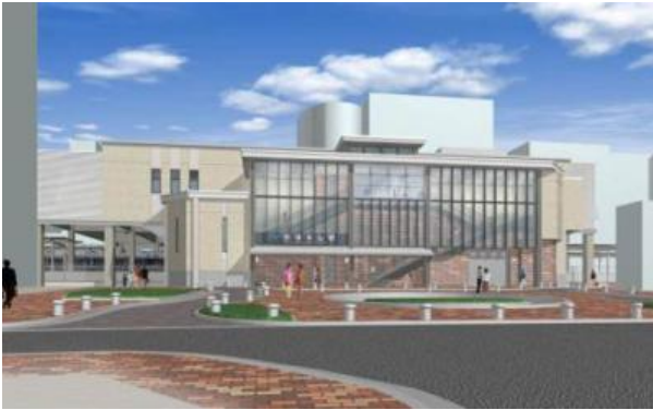
駅舎外観(南側)
