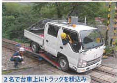
作業現場近くの踏切から載線開始
