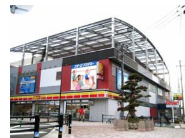
JR須磨海浜公園駅西NKビル (2009年9月開業)
