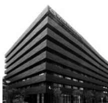
大阪北NKビル
