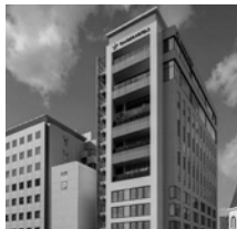
広島八丁堀NKビル
