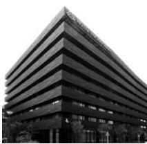
大阪北NKビル
