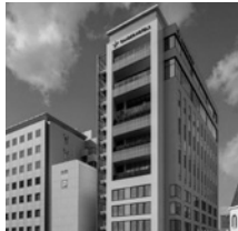
広島八丁堀NKビル
