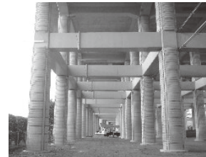
高架橋柱の耐震補強
