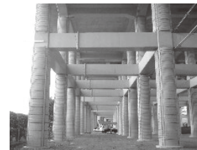
高架橋柱の耐震補強
